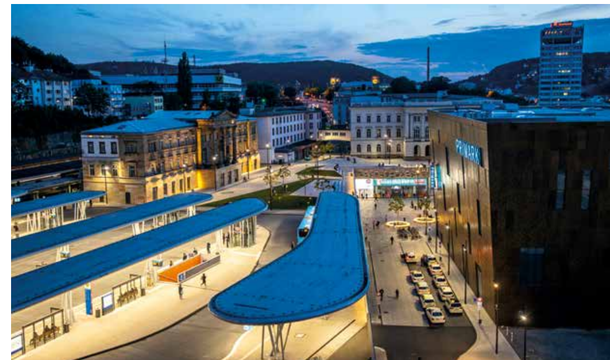
Hell, sicher und sauber: der zentrale Busbahnhof am Wuppertaler Hauptbahnhof.
